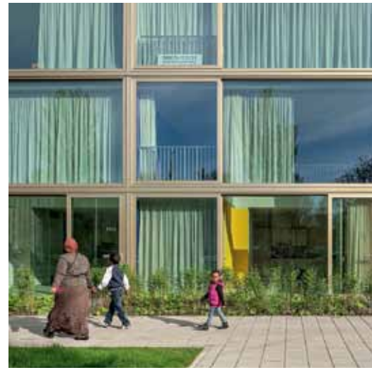
Für einen Wohnungsbau in Den Haag-Moerwijk entwickelten Kempe Thill eine Fassade, die im Werk vorgefertigt wurde. Die Aluminiumfensterrahmen und Abdeckbleche sind in dezenter Goldfarbe ausgeführt. Das Gebäude soll eine diskrete Noblesse ausstrahlen und das Stigma, dass sozialer Wohnungsbau nicht nur billig sein muss, sondern auch billig aussehen soll, durchbrechen. Foto: Ulrich Schwarz
